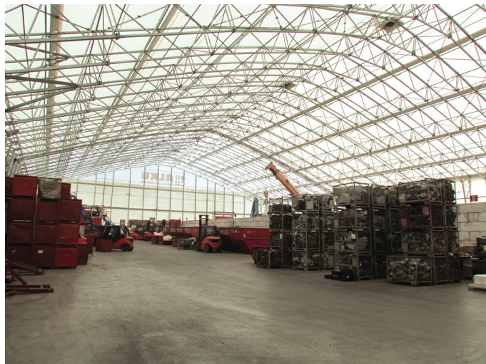
2011 wurde die freitragende Sortierhalle von ALKU erweitert
